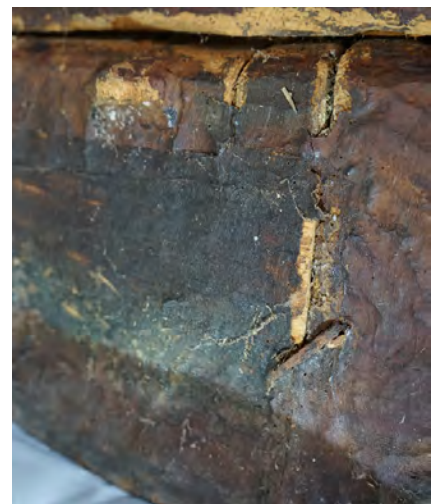
図16：像底の張り板
